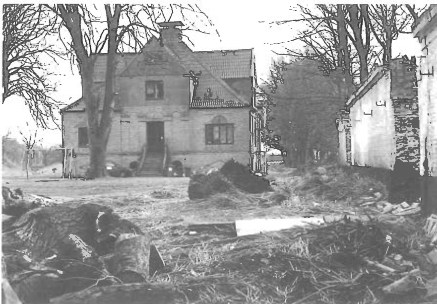
På Klusgård vidner alt i dag om forfald. De to store lader ligger i ruiner – overvokset af brændenælder og tidsler, og stuehuset er i opløsning. Alligevel aner man, at den store kvadratiske hovedbygning gemmer en historie ud over det almindelige. Foto Johannes Christiansen 1991.
