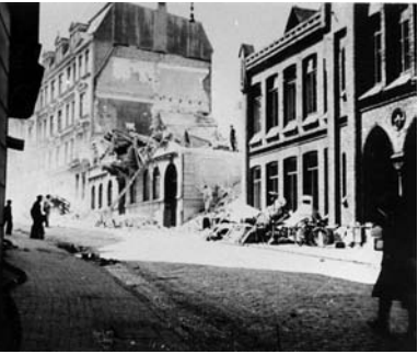
Das Nachbarhaus der dänischen Kommunalschule in der Duburger Straße in Flensburg wurde beim Bombenangriff vom 19. Mai 1943 völlig zerstört.
