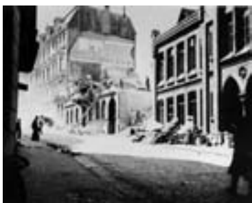
Nabohuset til den danske kommuneskole i Duborggade i Flensborg blev totalskadedet under bombardementet 19. maj 1943.
