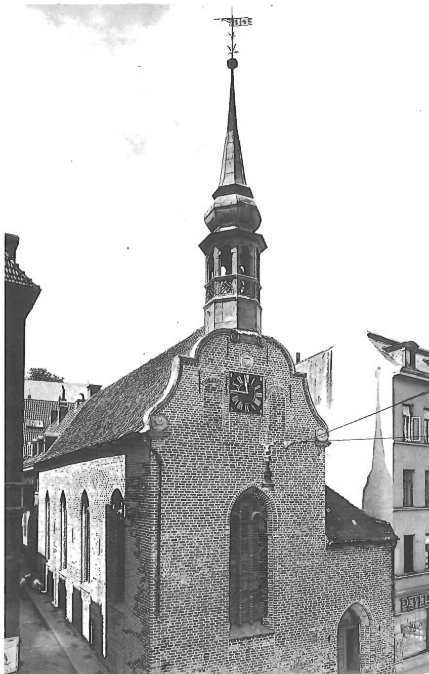
Efter den udvendige restaurering i 1935 fremstod kirken med mure i smukke frillagte munkesten. Nu pyntede bygningen virkelig i gaden – i de foregående år havde murene stået med grå maling, slemt afskallet og medtaget. Foto Th. Thomsen, Flensborg.
