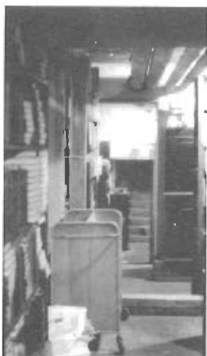
Et kikk ind i det overfyldte bogmagasin under Flensborghus før 1959. Loftet er understøttet med solide bjælker, og mange vandrør løber hen over reolerne.
