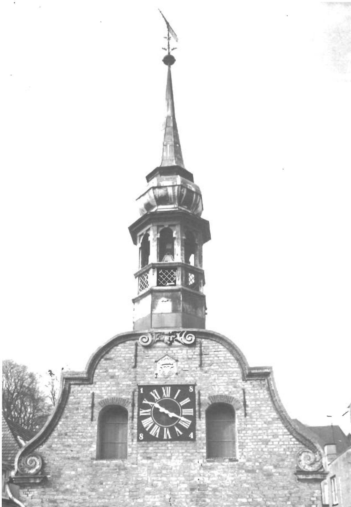
8. Tagrytteren samt underliggende detaljer fra facadeombygnigen 1761.
