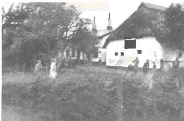
Tarup skole indtil 1938. Til højre udhuset med Bergers hønsehus og skolens lokummer (bag de to tætsiddende vinduer). Bag ved skimtes selve »skolen«
