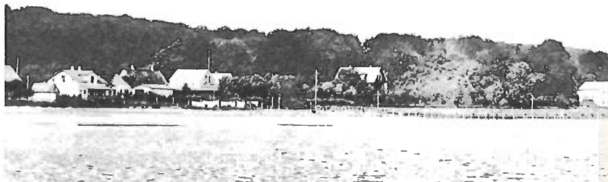
Sosti ligger ved Flensborg fjord på landevejen mellem Flensborg og Kruså, indtil grænsedragningen i 1920 endnu i Bov sogn. Tyskerne kalder stedet Wassersleben, fordi konferensråd Joachim Wasserschlebe, Bernstorffs medarbejder og ven, med Bernstorff slot som forbillede kaldte sit hus i Sosti op efter sig selv. Foto 1892.
