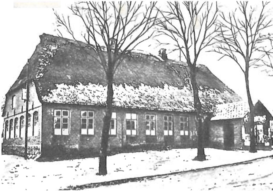
Sørup skole. Bygget 1839 med 2 klasseværelser til 239 børn, 1859 udvidet med den tredje skolestue. Nedrevet 1927.
