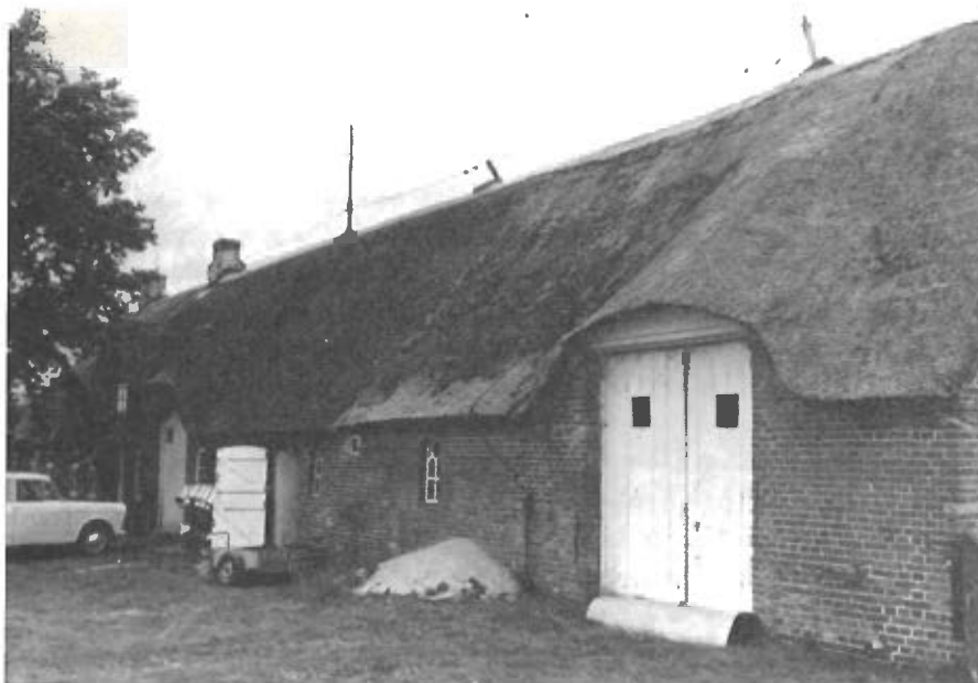
Denne gård i Horsted, Hatsted sogn, er opført i 1850'erne af røde mursten. Gården består af én lang længe med bolig i vest, lo i midten og stald i øst, hvortil kommer en vognport til. Denne type er meget gammel og har stor udbredelse i Gøs herrederne og det øvrige Sønderjylland.
